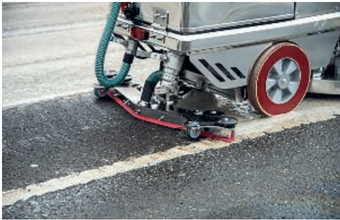
Sonderreinigung: Das im Markt in Bornheim verwendete Scheuersaugfahrzeug lässt sich in Verbindung mit einem Intensivreiniger bei Bedarf auch bei Ölverschmutzungen auf den Parkflächen einsetzen.
